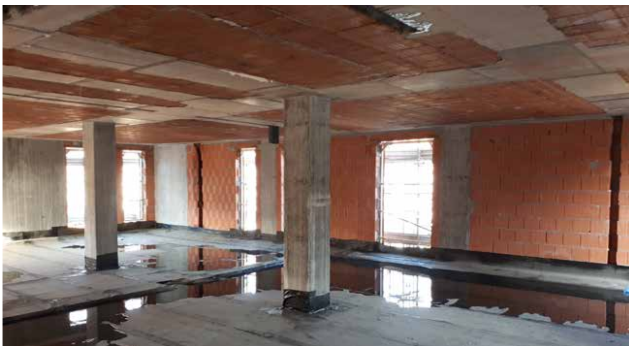
Murature di tamponamento e solai in laterizio.
